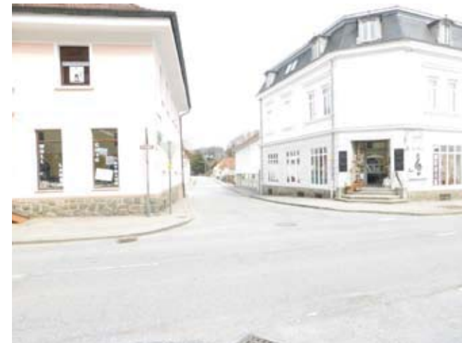
Abb. 2.37 Einmündung Kirchenweg in den Marktplatz: sehr schmale Gehwege, keine Bordsteinabsenkungen
