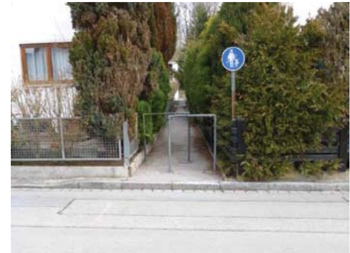
Abb. 2.44 Durchgang Gabingerweg – Weinhügelparkplatz: nur eingeschränkt nutzbar und abends und nachts auf Grund fehlender Beleuchtung unsicher
