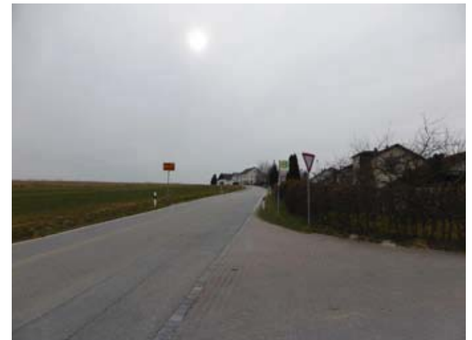
Abb. 2.48 Haltestelle Griesbacher Straße (Richtung Bad Griesbach)
