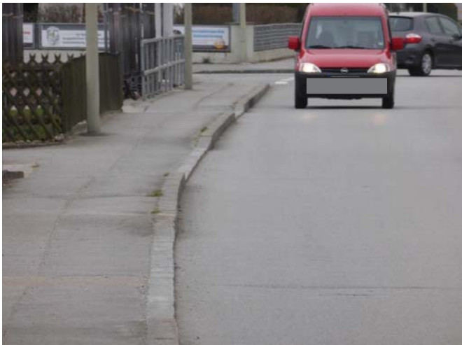
Abb. 2.40 Gehweg Bahnhofstraße: Unebene Oberfläche
