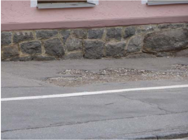
Abb. 2.39 Marktplatz: Beschädigter Gehwegbelag
